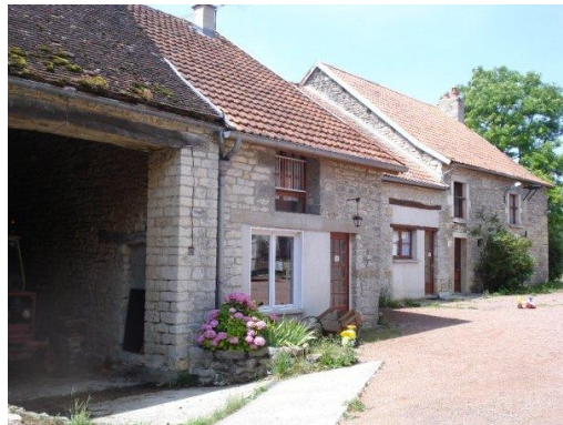
2 – Ancien corps de ferme réhabilité
